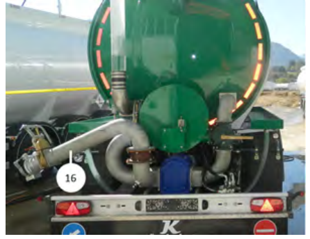
Boşaltım pompa çıkış hattı
