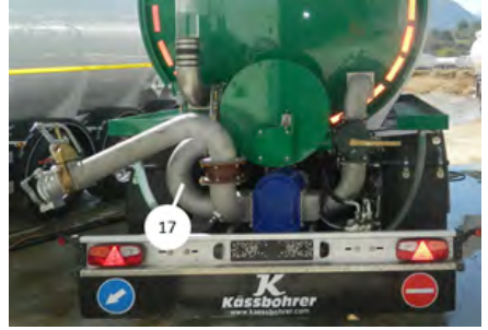
Tank karıştırma pompa giriş hattı
