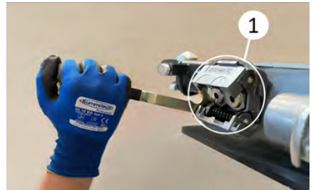
Duomatic kaplin bağlantısının yapılması
