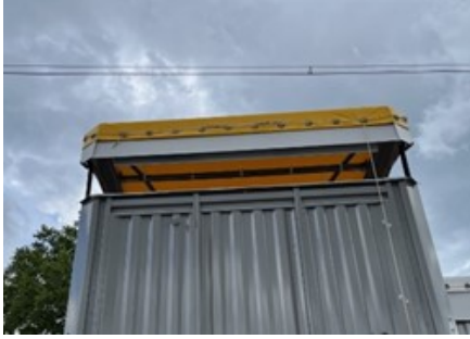
Çatının kaldırılması
