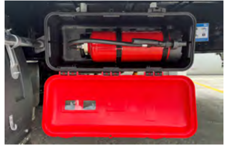
Yangın söndürme tüpü dolabının açılması
