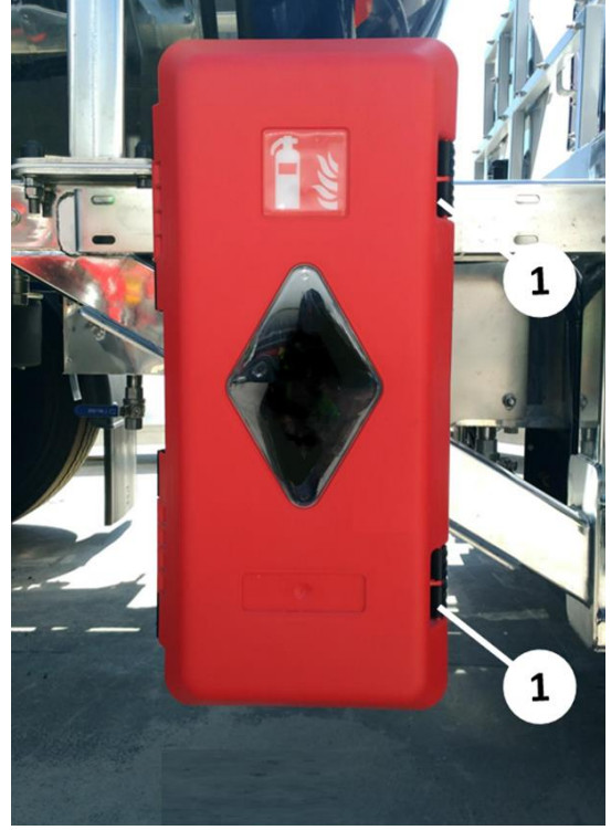
Yangın söndürme tüpü dolabı
