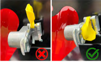
Bağlantı ağızlarının kapatılması
